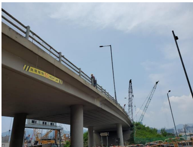
Le pont surveillé par HAPPY MONITORING
