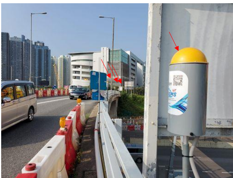
Vue des 4 Rover HAPPY HAWK (flèches) sur la corniche et le garde-corps Est
